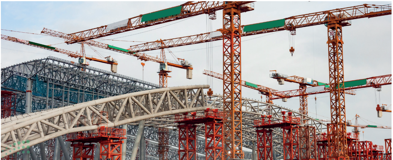
شكل 1.8: إنشاء قطار الأنفاق (المترو) في الرياض
