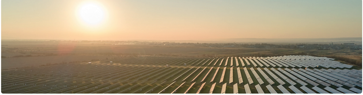
شكل 1.9: الطاقة الكهربائية النظيفة من الألواح الكهروضوئية الشمسية
