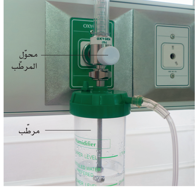
الشكل "57-3 أ" عندما يُضخ الأكسجين عبر الحائط، يوصل مقياس التدفق بمحلول الحائط. يستخدم المرطب لترطيب الأكسجين.
