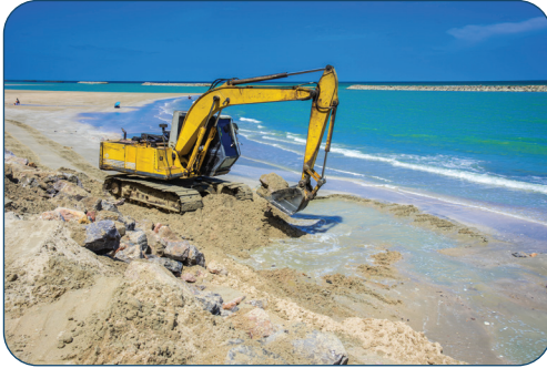
شكل 8-24 تجريف مياه البحر.
