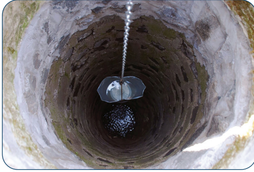
شكل 3-8 آبار المياه الجوفية
