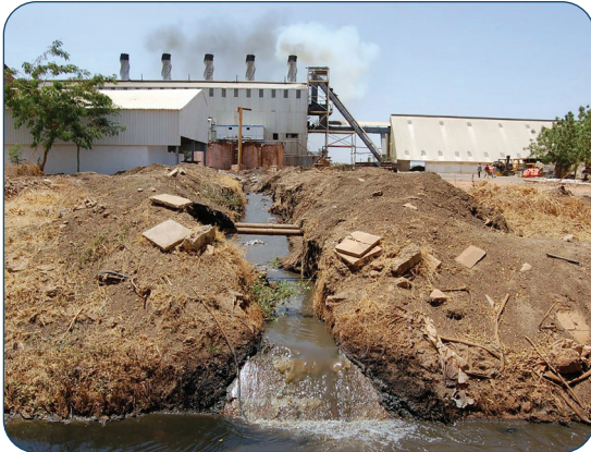
شكل 20-8 مخلفات الصرف الصناعي
